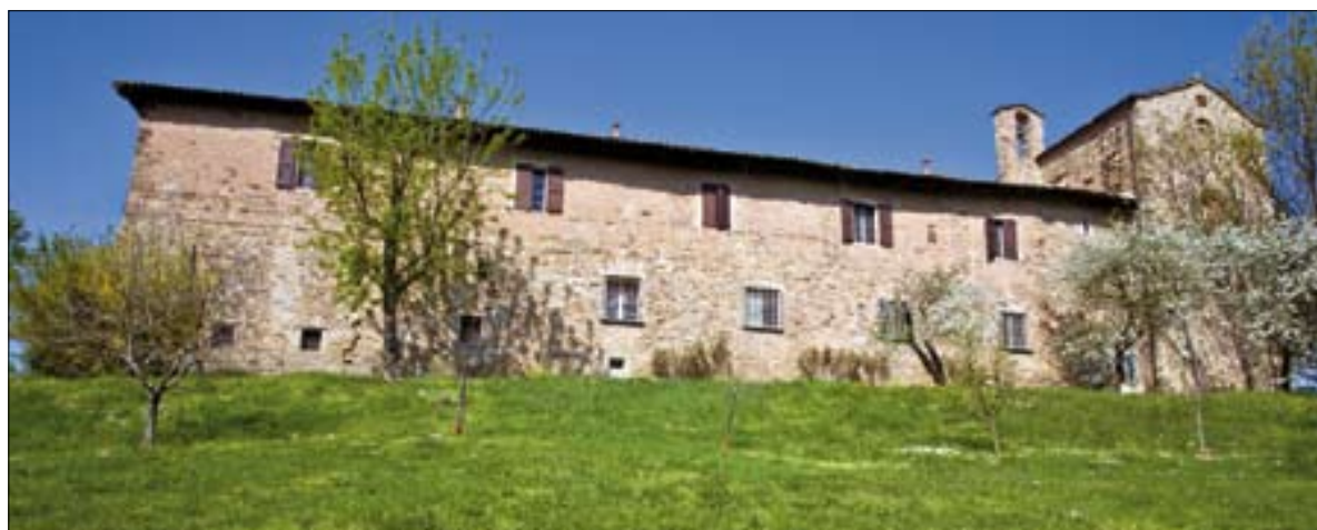
Vista dal parco
